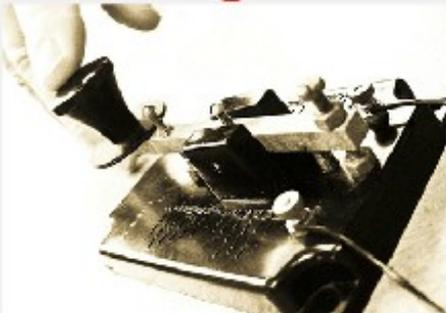
El telégrafo es un dispositivo destinado a la transmisión de señales a distancia que aparece hacia 1832. Al principio no existía ningún código para comunicarse hasta que Morse creó un alfabeto basado en la amplitud de las señales: señal corta es un punto (.), señal larga una raya (-)
