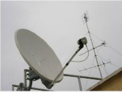
Las antenas utilizadas preferentemente en las comunicaciones vía satélites son las antenas parabólicas. La forma de parábola hace que se concentre la señal de las ondas provenientes del satélite en un elemento receptor.
